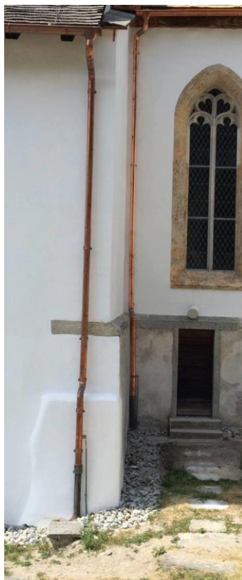
Passivation du cuivre sur les gouttières Ernen (Valais Suisse, juillet 2018)
